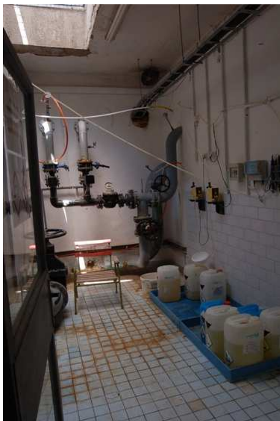
gépház, vegyszeradagoló
