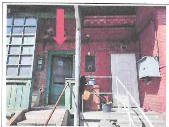
lakás bejárati ajtó
