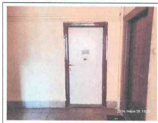
Lakás bejárati ajtó
