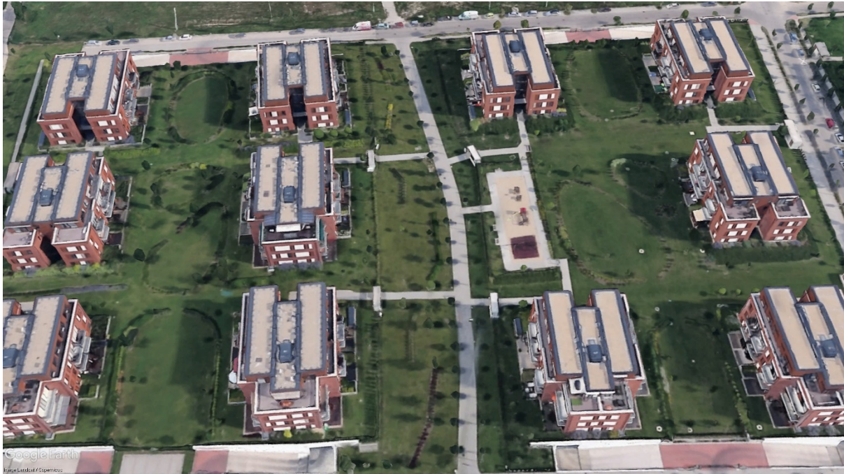
Beépítettség, burkolt felületek és zöldfelületek jó aránya. Gépkocsitárolás épületek alatti, egyesített teremgarázsban. Privát, félprivát és publikus zöldterületek fokozatos átmenete. (Madárhegy, forrás: Google Earth)
