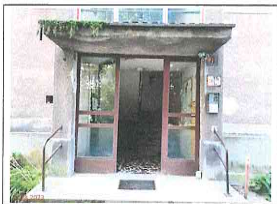
lépcsőház bejárati ajtó
