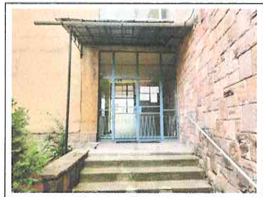
lépcsőház bejárati ajtó
