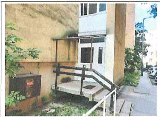
lépcsőház bejárati ajtó
