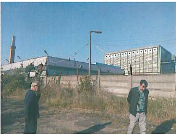
A szomszédos ingatlanon üzemelő hűtőház...
