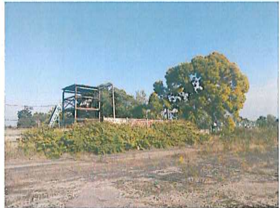
...és felhagyott ipari építmények (11042/1 hrsz.)
