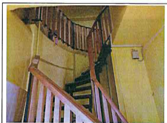
Új épületrész - tetőtér
