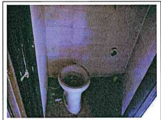
Új épületrész - tetőtér
