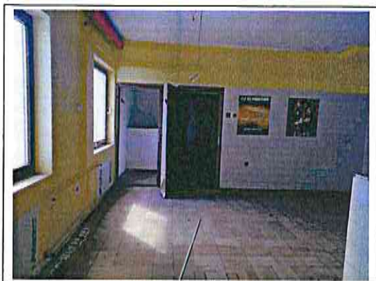
Új épületrész - földszint
