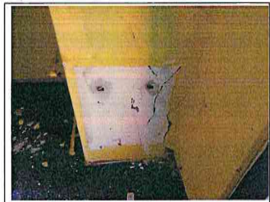
Új épületrész - tetőtér
