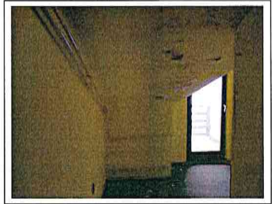
Új épületrész - tetőtér
