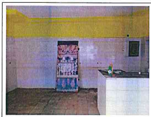
Új épületrész - földszint
