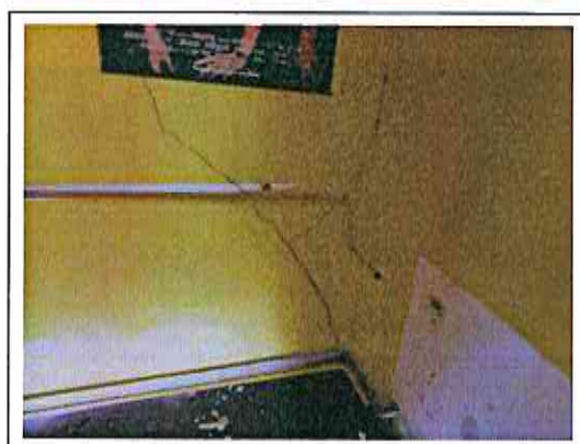
Új épületrész - tetőtér
