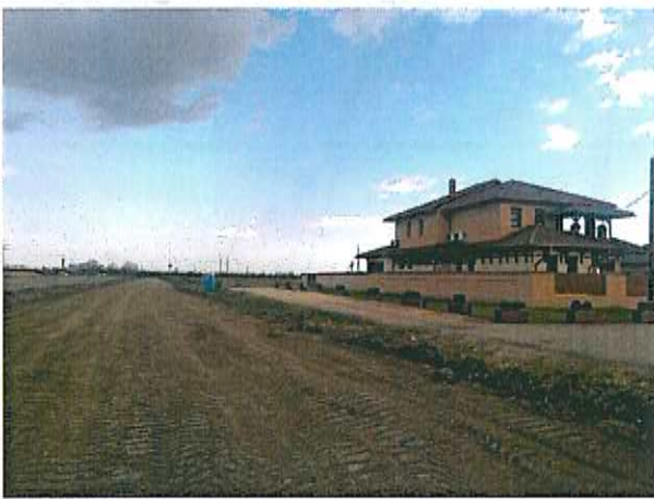
Szalay utca – Csokonai utca sarok az épülő úttal
