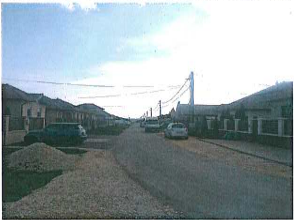
A Lajos Árpád utca kiépült szakasza
