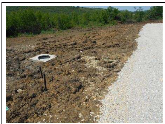
Szennyvízvezeték bekötés a szemben lévő telken
