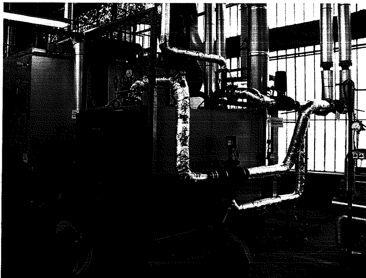
4. ábra: Korszerű biogáz üzemű kazán
